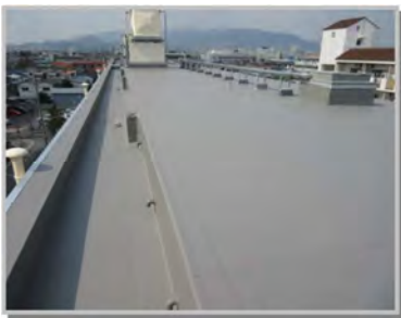
環境配慮型露出断熱防水工法 ネオハードフォーム防水工法
